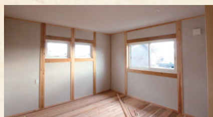
6 柱と梁が見える真壁づくり
